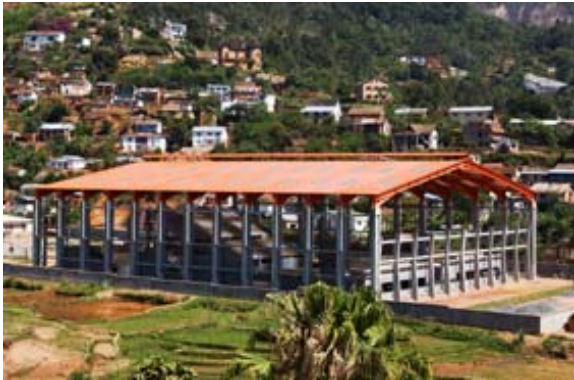
Neue Sporthalle (2004) im Bau
