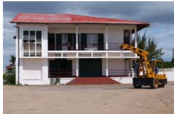
Zollgebäude am Hafen
