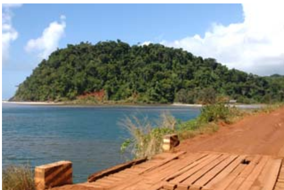
Damm mit Brücken an der RN 5a und...
