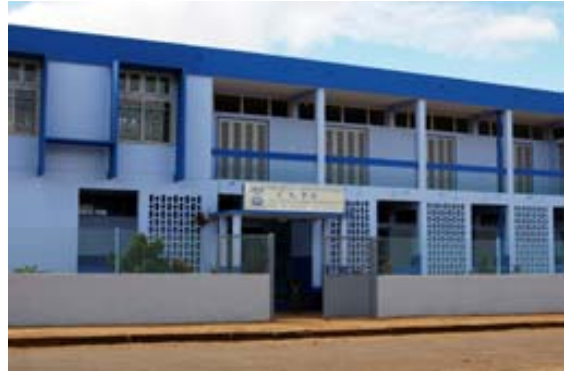
Bâtiment de la CNAPS – la Caisse Nationale de Prévoyance Sociale (AHV et SUVA)
